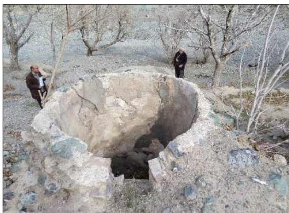
تصویر ۸. تنوره آسیاب پایین حاجی عباسعلی کاسه‌سنگی با قطر زیاد (عکس از: نجف‌زاده، ۱۳۹۴).
