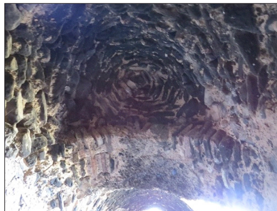
تصویر ۱۵. پوشش سقف فضای آسیاب کربلایی غلام (عکس از: محمودی‌نسب، ۱۳۹۲).
