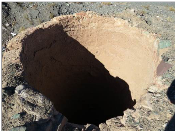
تصویر ۷. تنوره آسیاب کربلایی غلام با قطر کم (عکس از: نجف‌زاده، ۱۳۹۴).
